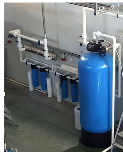
Automatski deferizator sa Clack WS1.5CI upravljачkim ventilom
